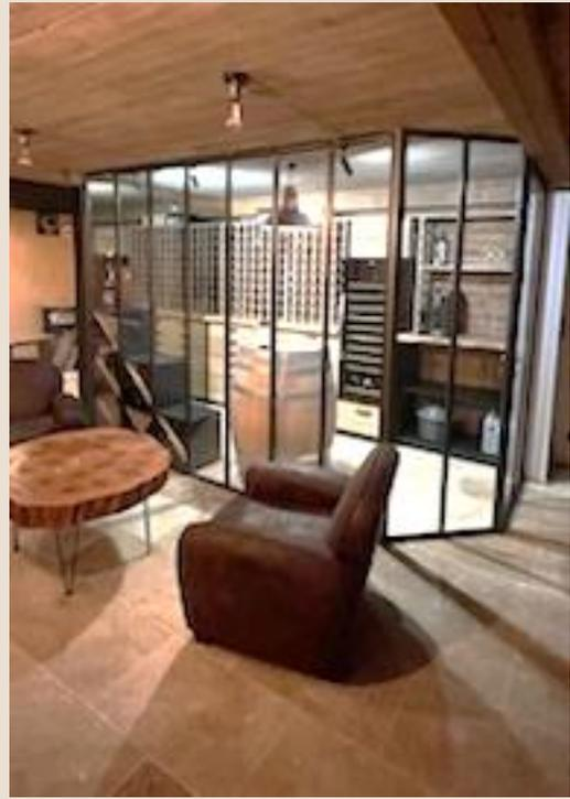
GAMME PREMIUM : Assemblage Soudé, tubes 35x35mm / tube ailette soudé.
